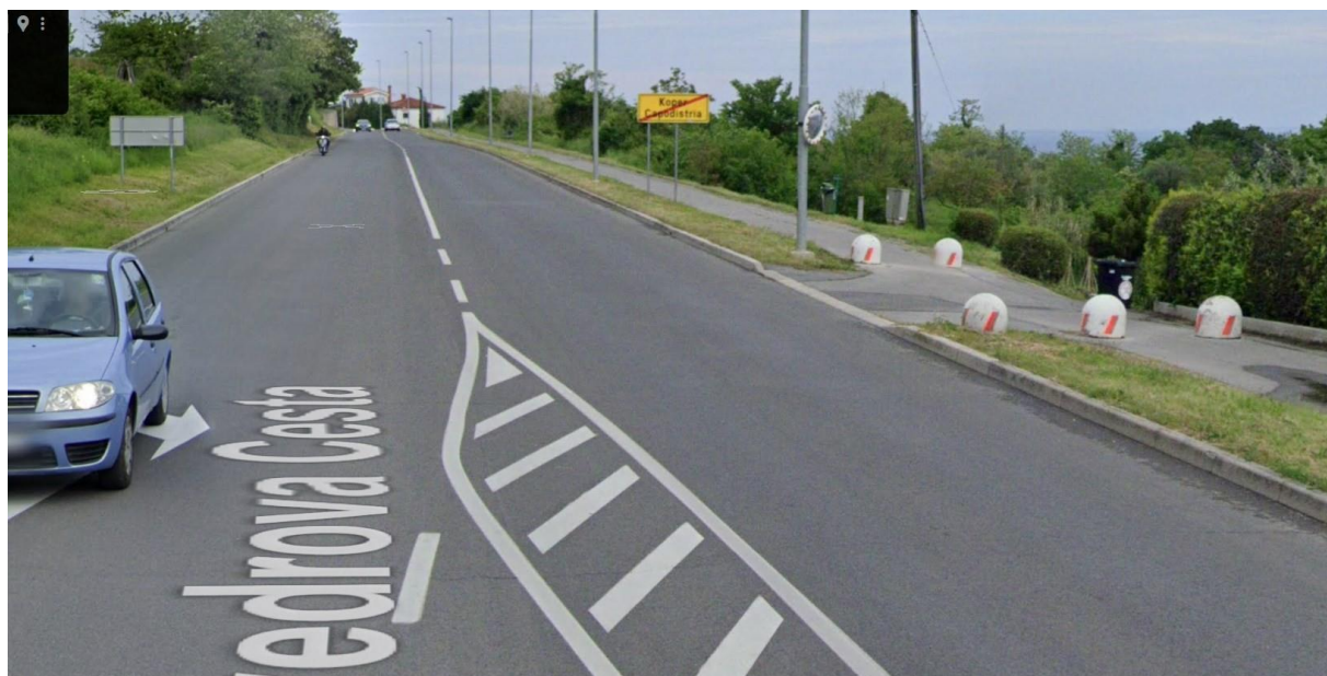
Slika 2: Elementi lokalne ceste v obstoječem stanju – odsek pri zaključku naselja Koper
