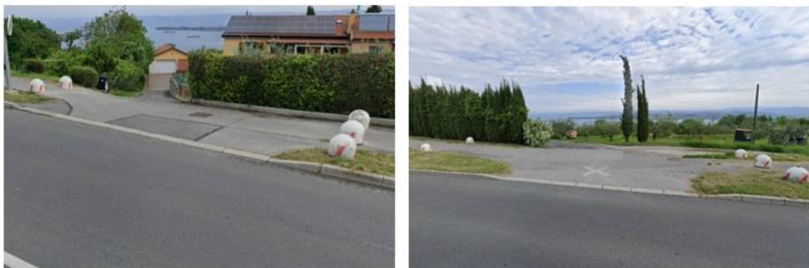
Slika 7: Obstoječa priključka na lokalno cesto
