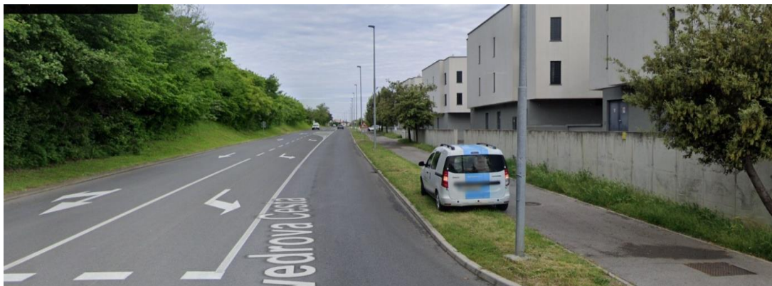
Slika 6: Elementi lokalne ceste v obstoječem stanju – odsek pri križišču s Kozlovičevo ulico
